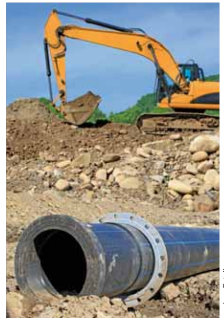
Travaux de réhabilitation.
