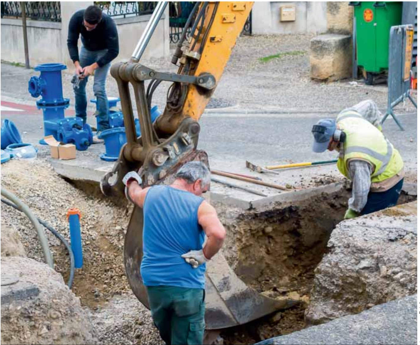
Travaux de réfection d'un réseau d'eau.
